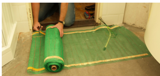
Uitrollen van het verwarmingselement
