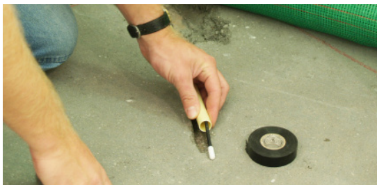
Installatie vloervoeler
