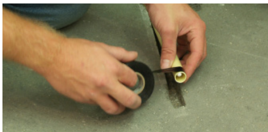
Duw de voelersdraad vervolgens aan het einde terug en tape of dop deze zorgvuldig af.
