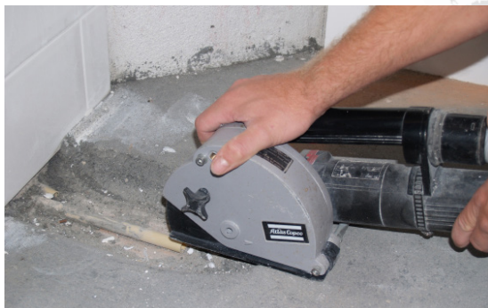
Sleuf maken vloervoeler
