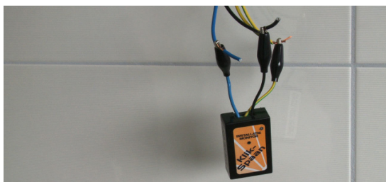
Klikspaan aansluiten tijdens het tegelen
