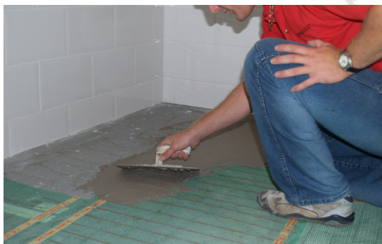
Opvullen putje met cementmortel
