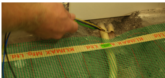
Doorvoeren draad
