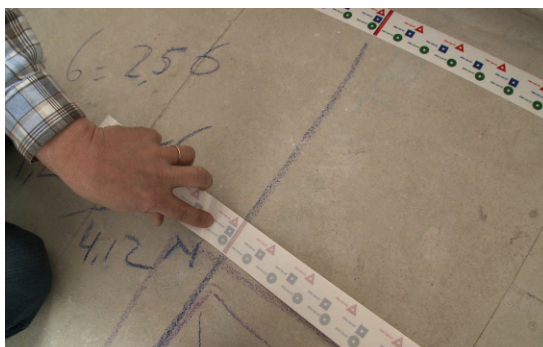
Zet op een regelmatige afstand een tweede tape
