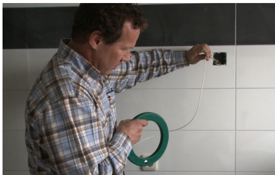
Invoeren van trekveer in invoerbuis
