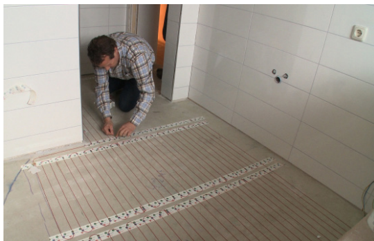
Werk de draad in zijn geheel op
