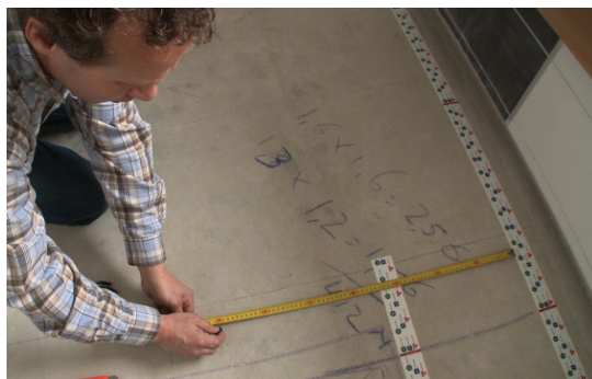
Werk bij voorkeur vanaf het verste punt terug naar de trekveer
