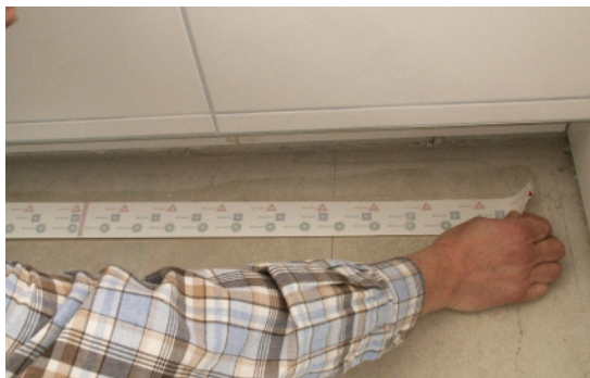
Kleef de afstandstape op de vloer
